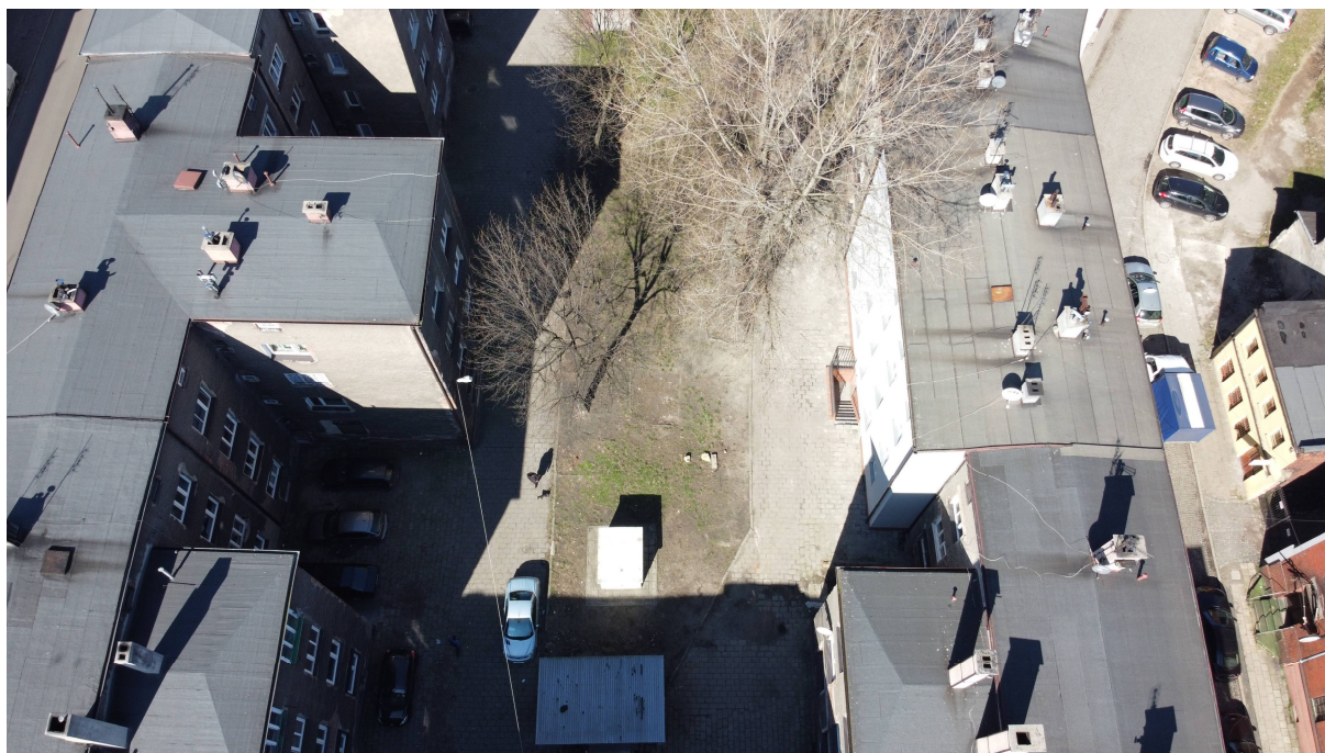
Rys. nr 6. Widok ogólny.
