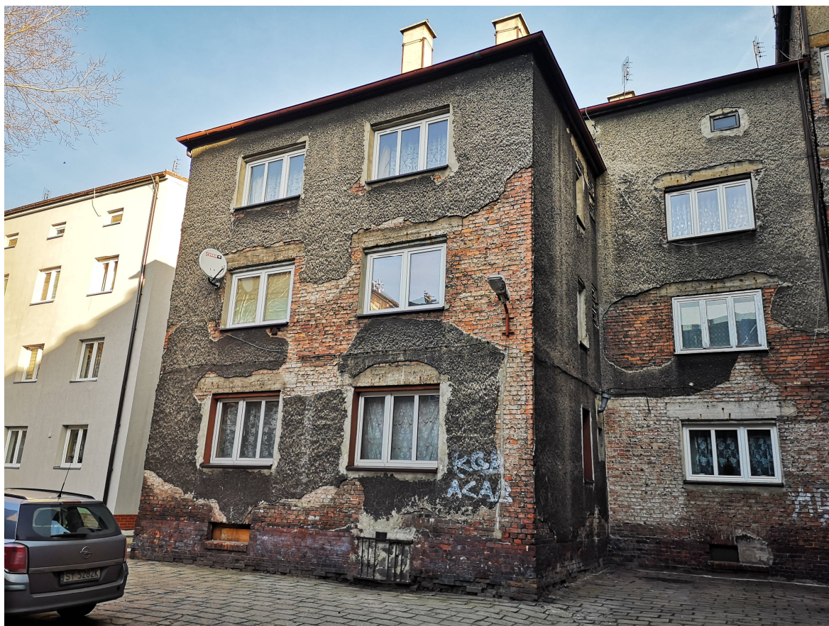
Rys. nr 4. Widok ogólny elewacji tylnej.
