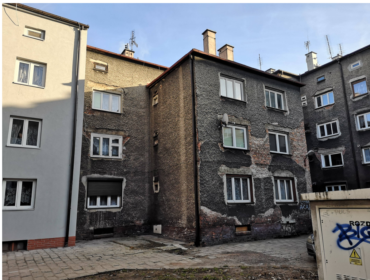
Rys. nr 5. Widok ogólny elewacji tylnej.
