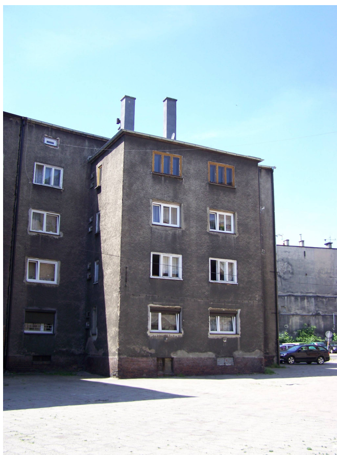
Rys. nr 4. Widok ogólny elewacji szczytowej.
