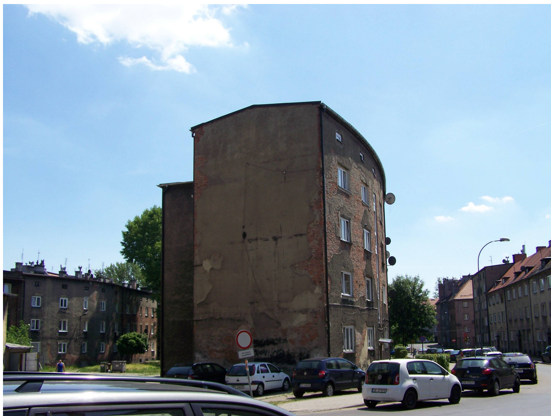
Rys. nr 3. Widok ogólny elewacji od strony podwórza budynku.
