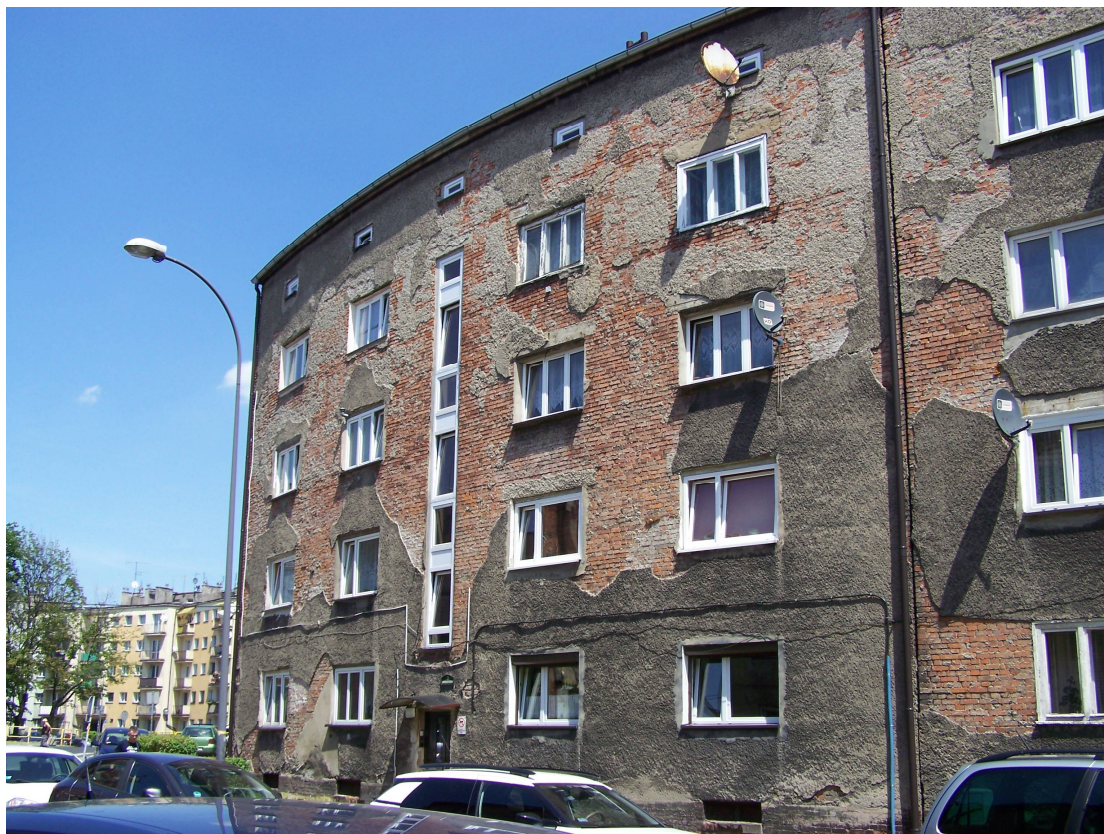
Rys. nr 2. Widok ogólny elewacji frontowej (wejściowej) budynku.
