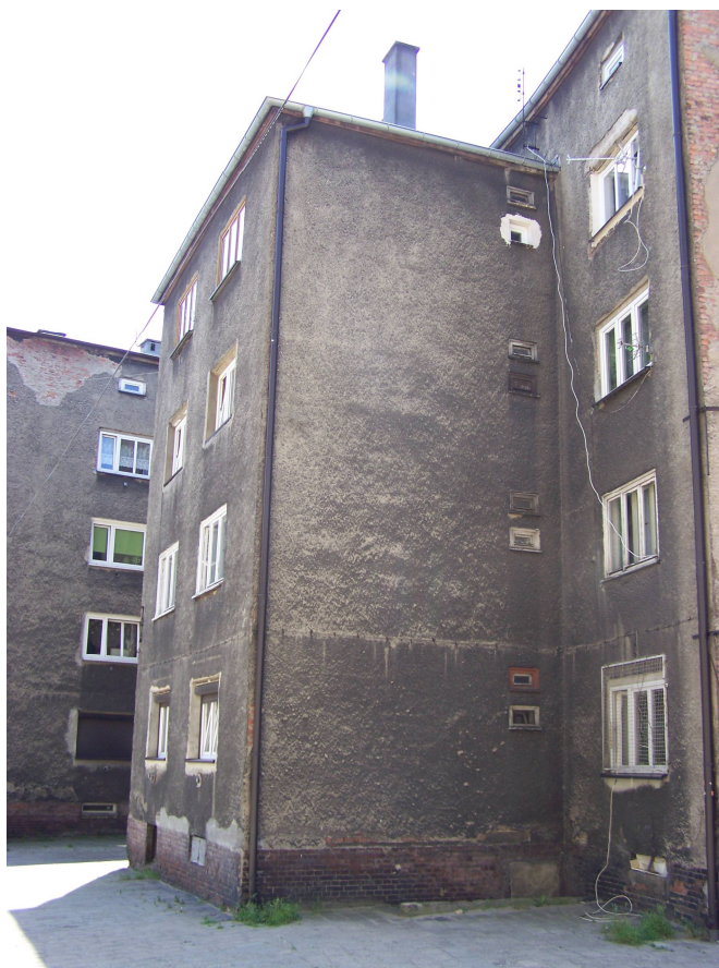
Rys. nr 5. Widok ogólny elewacji szczytowej.
