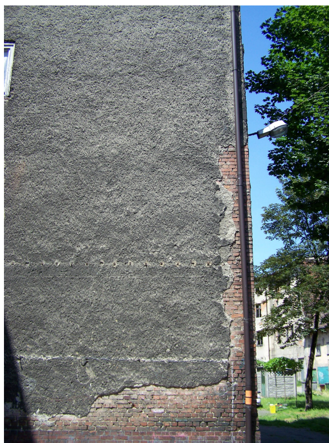
Rys. nr 6-18. Wybrane uszkodzenia dla całego budynku.
