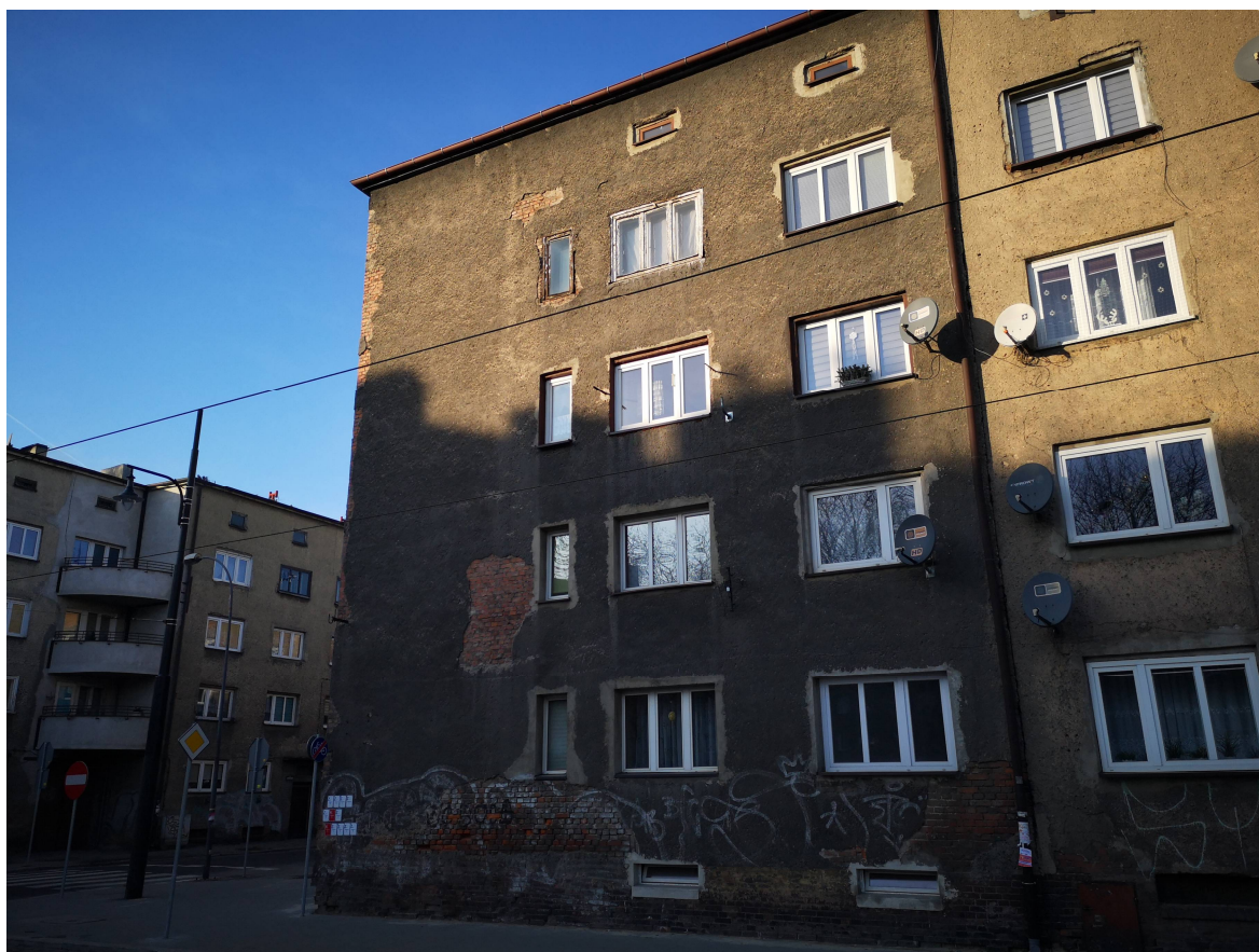
Rys. nr 3. Widok ogólny elewacji od frontu.
