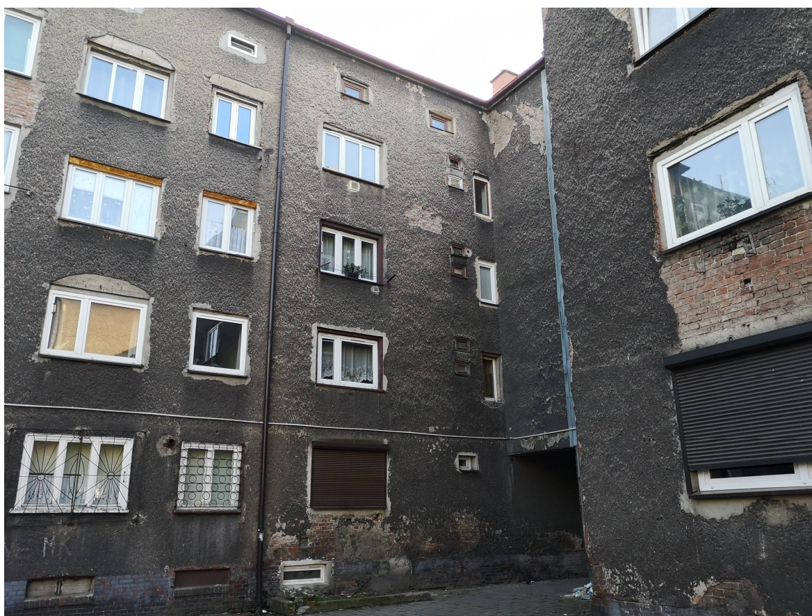
Rys. nr 4. Widok ogólny elewacji tylnej.
