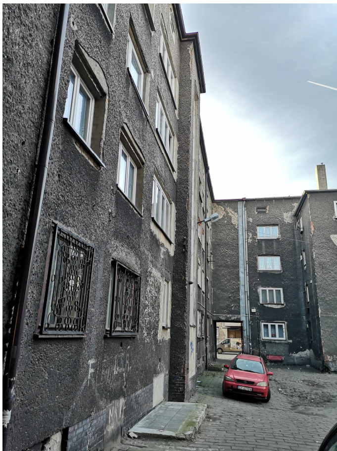
Rys. nr 5. Widok ogólny elewacji tylnej.
